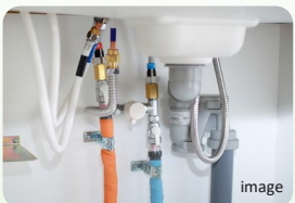
配管更新(漏水対策)
